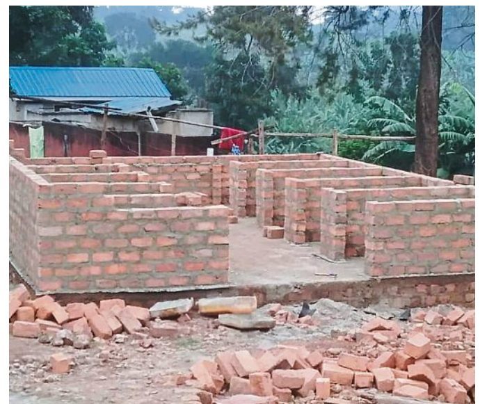
Rohbau der neuen Latrine für die Zoe-Grundschule.
