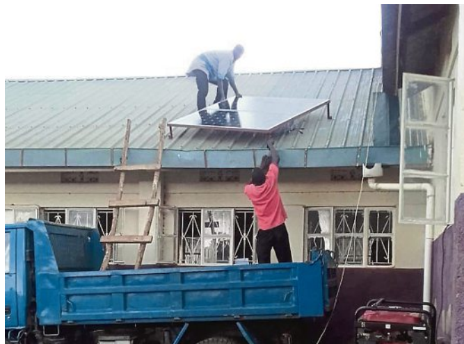
Montage der Solarkollektoren: Mit den Spenden der Sternsinger konnten bereits letztes Jahr Solarkollektoren in St. Zoe installiert werden. Dadurch hat sich die Stromversorgung deutlich verbessert. Foto: Privat
