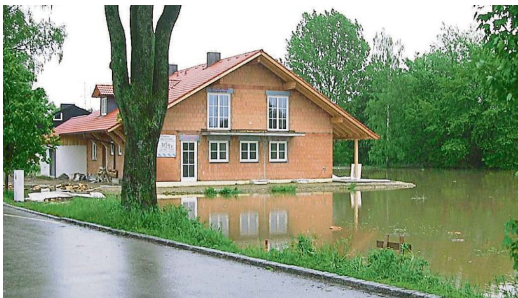
Eching: Nahe am Wasser gebaut: Blick von der Stegener Straße in Eching Richtung Südosten zum Ammersee. Die Windach überflutet die Uferwiesen, die Holzbrücke in Eching ist wegen der großen Menge von verkeiltem Treibholz zeitweise unbefahrbar.
