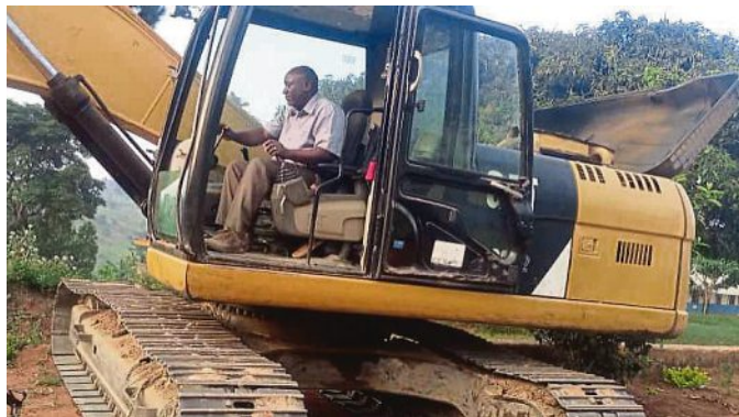
Schwierige Hanglage in St. Zoe: Mit Baggerarbeiten...
