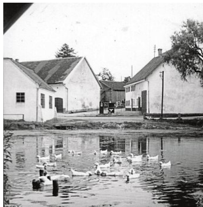
Links die Schmiede , dann die Tankstelle in einer frühen Bauphase. Sicht vom Weihermetzger aus.
