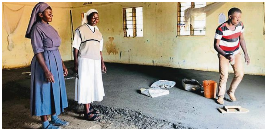
In den Schlafräumen der Internatsschüler wird der Boden erneuert,
