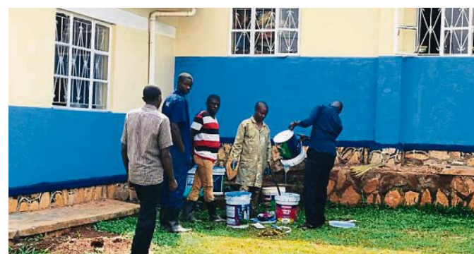
... zusätzlich werden defekte Fenster ausgetauscht.
