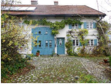
D-1-79-149-7 Echinger Straße 5, Zanken- hausen
