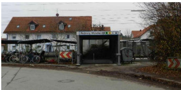
Abbildung 35: Blick auf die Bahnsteigunterführung – Bahnhof Türkenfeld (Quelle: eigene Aufnahme)
